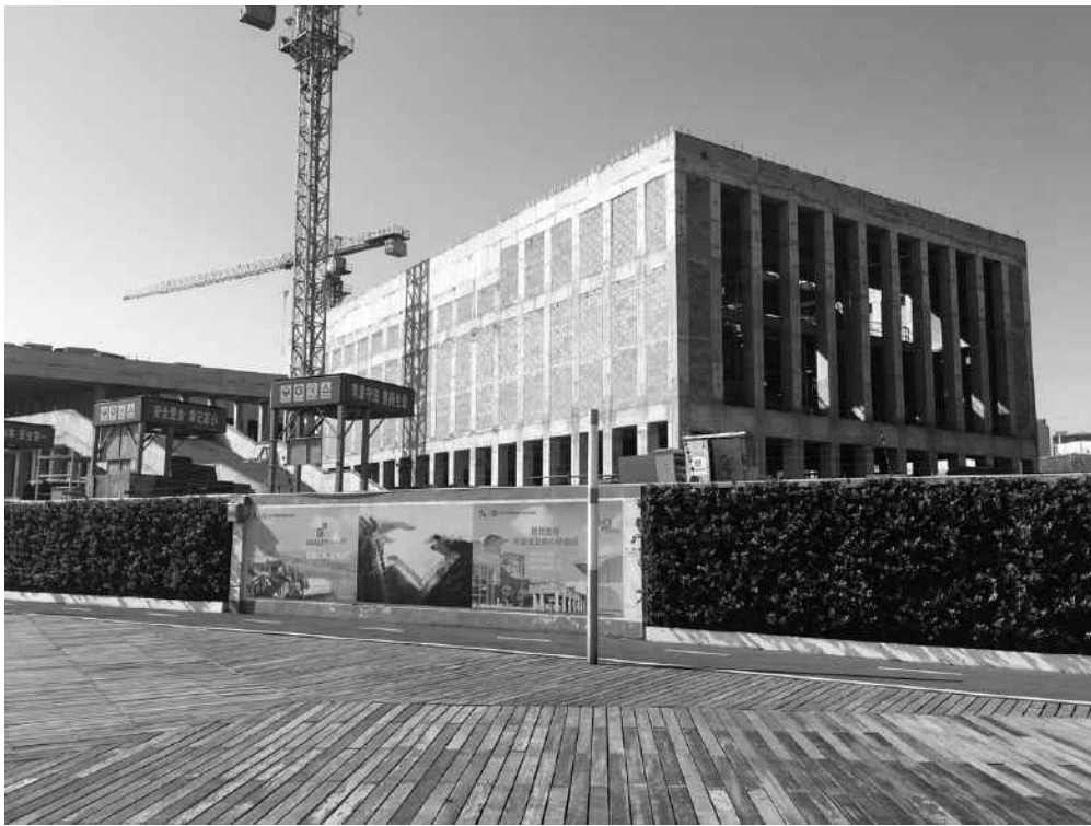
VUE DU BÂTIMENT EN COURS DE CONSTRUCTION © SÉBASTIEN DUGAUGUEZ
